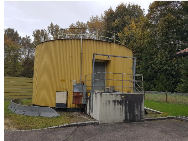
Bild: alter Gasspeicher
