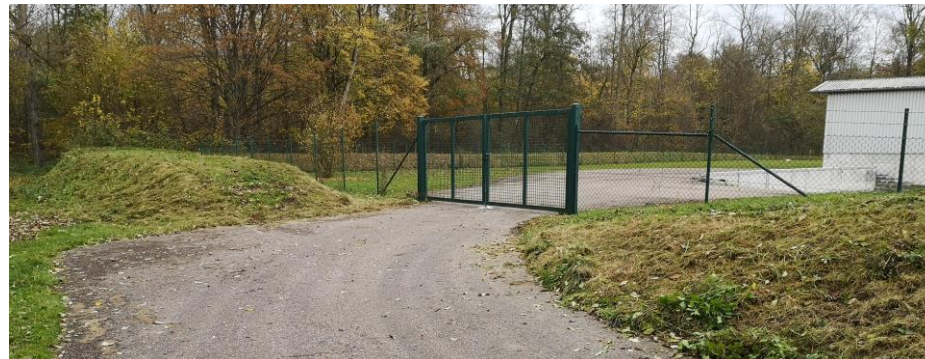
Bilder: bestehender Damm im Bereich der Zufahrten
