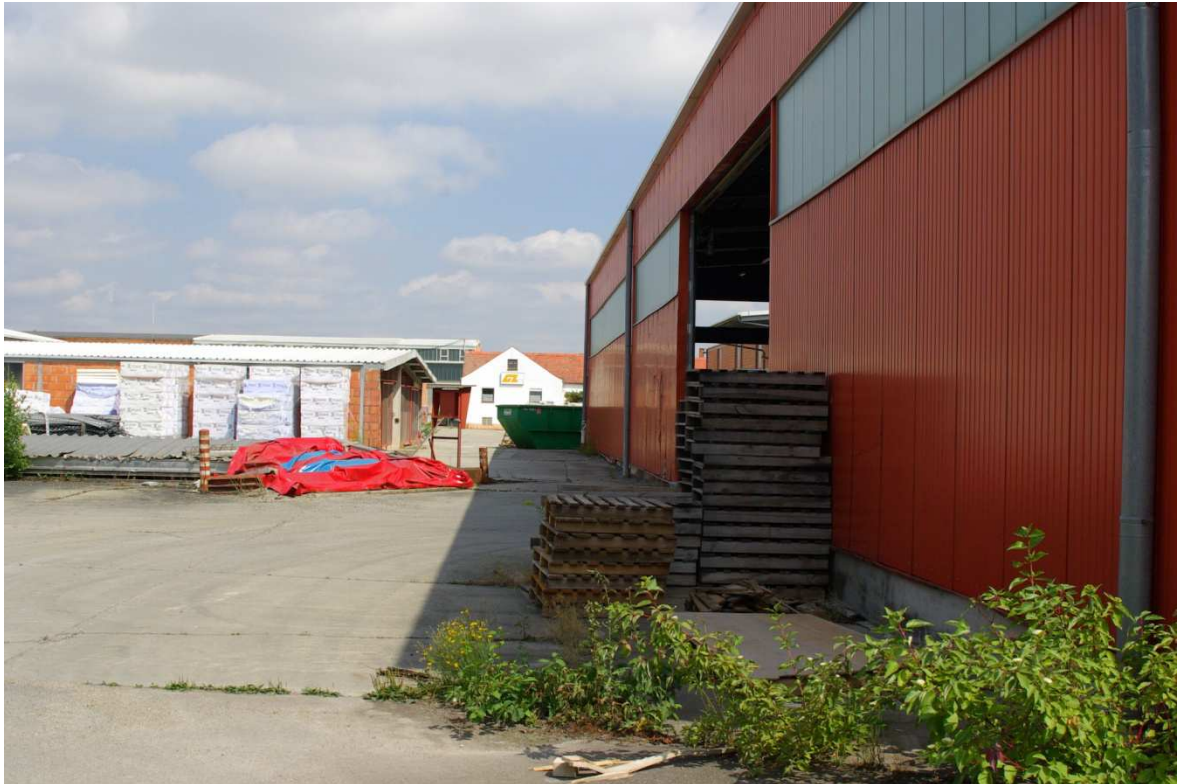
Abb. 7 : Betriebsgelände im südlichen Bereich.
