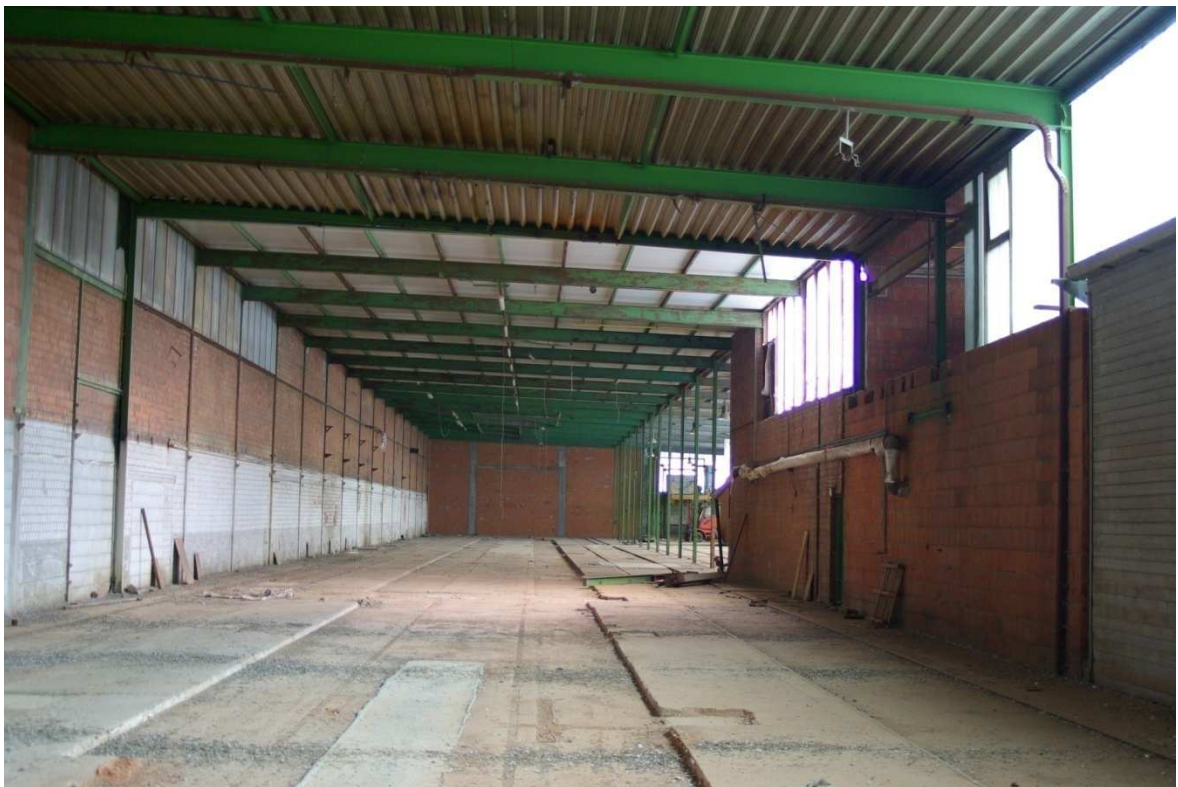
Abb. 6: Stillgelegte Werkshalle im nördlichen Bereich.
