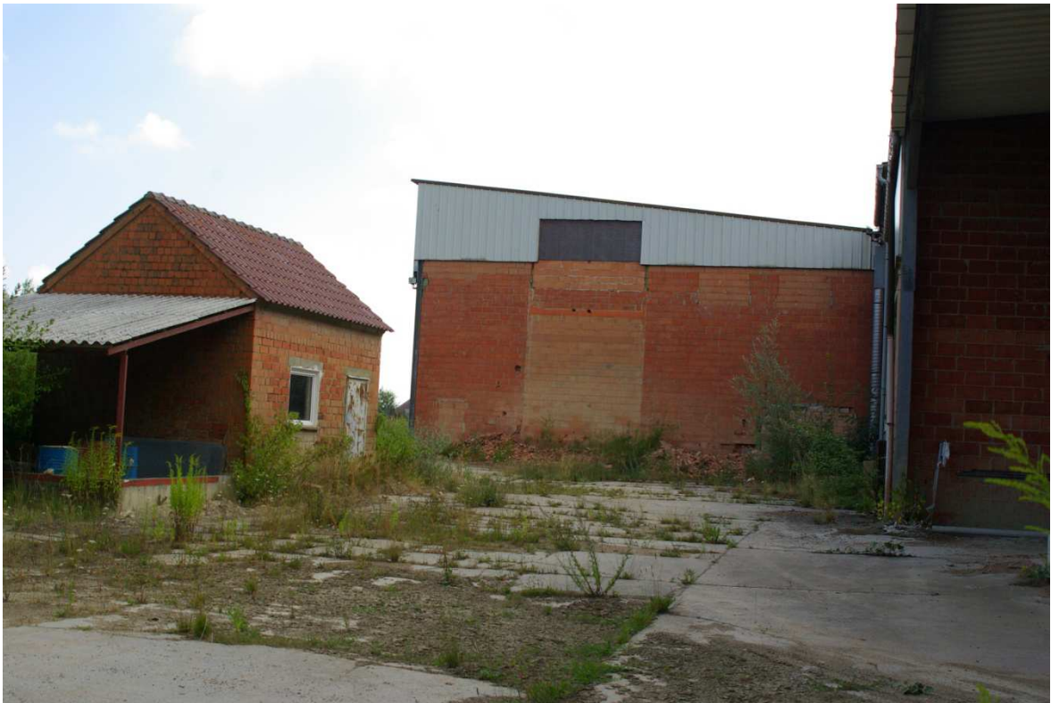
Abb. 5: Werkshallen im nördlichen Bereich.
